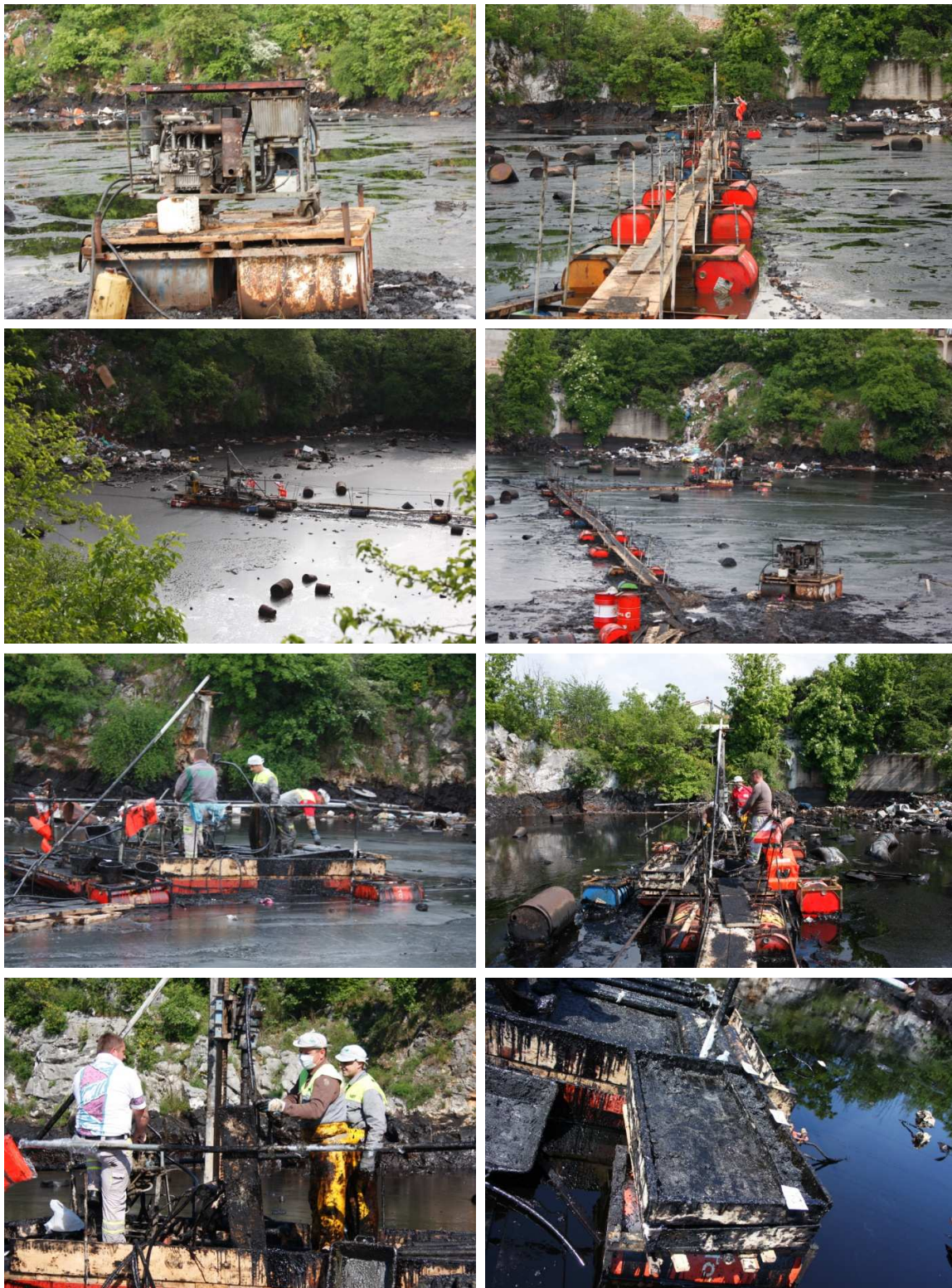
Slika 4. Radovi bušenja u razdoblju 22.04. – 08.05.2014.
