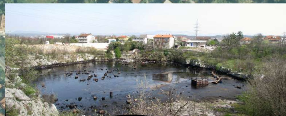
Slika 5. Pogled sa J strane granice obuhvata na jamu Sovjak i naselje u pozadini
